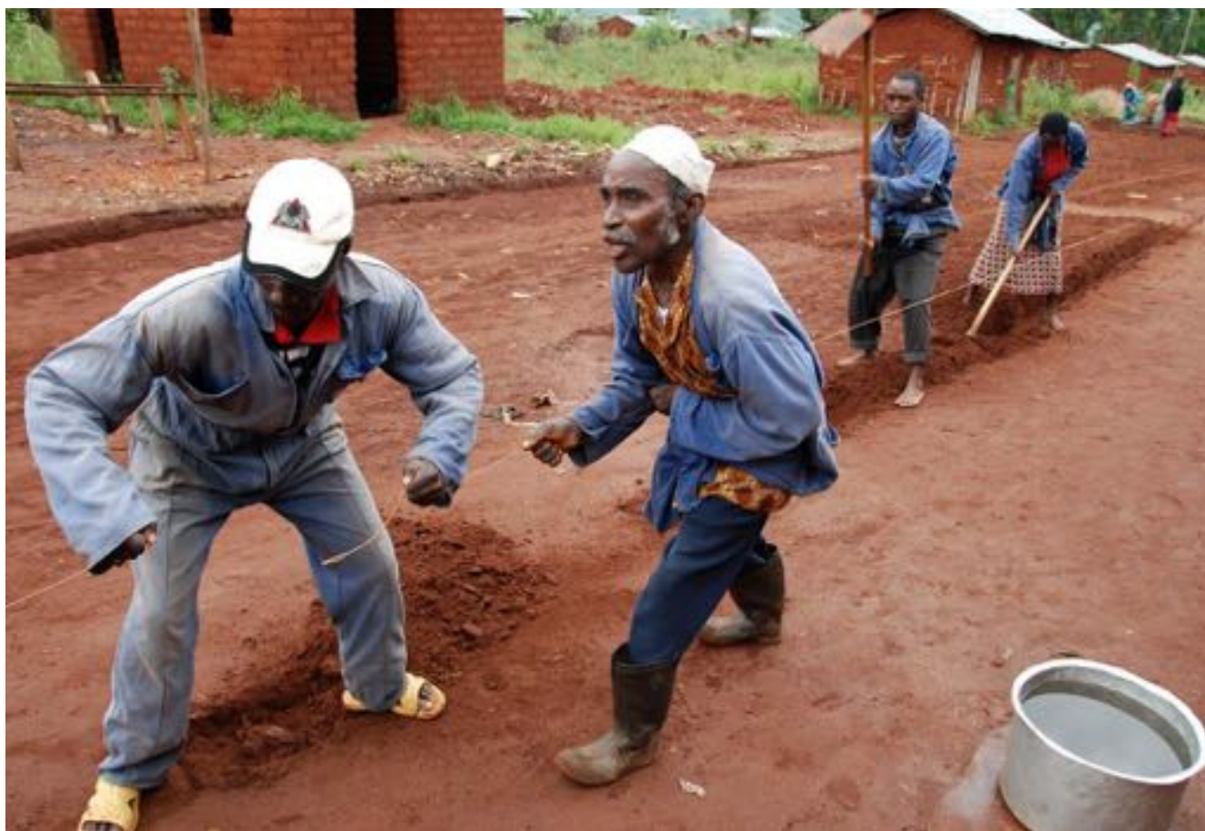
Los voluntarios locales trabajan juntos para construir una carretera para su comunidad en Burundi (UNDP Burundi/Aude Rossignol, 2013).
